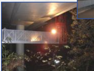
... und unter der Brücke
