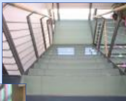
Glastreppe im Kundenbereich
