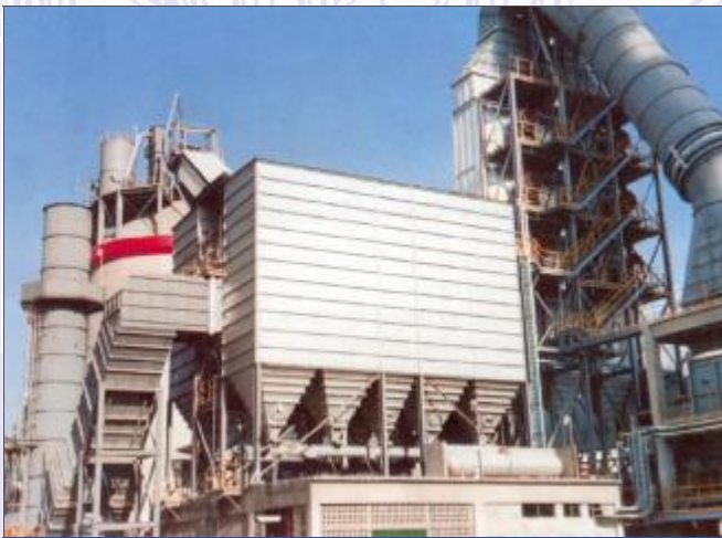
Elektrofilteranlage
