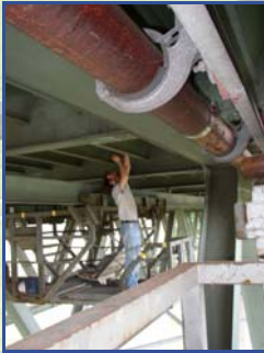
Prüfung der orthotropen Fahrbahnplatte
